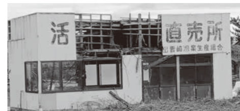
解体予定の建物
