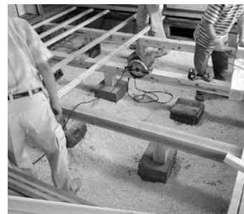
地域の皆さんとの修繕状況
