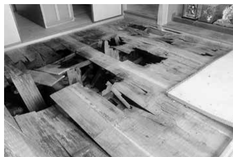
入居後、修繕前の状況
