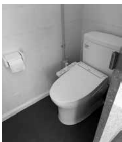
改修後のトイレ
