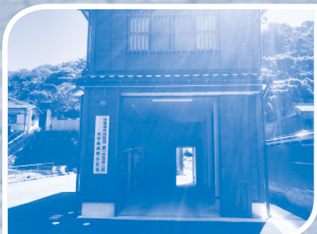
消防詰所兼資機材倉庫建築
