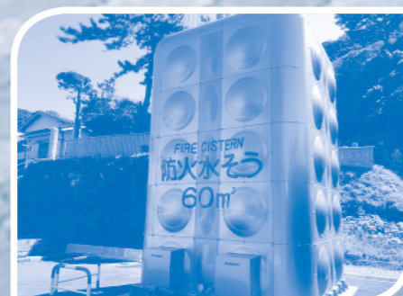
防火水槽設置
