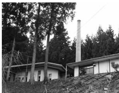
老朽化の進む与板斎場
