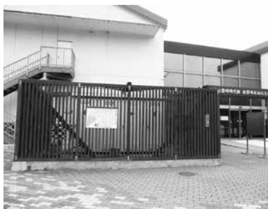
完了した囲い
