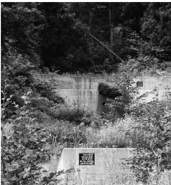
吉川砂防ダム
