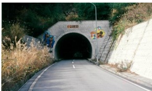
稲川トンネル
