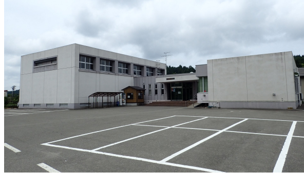
八手地区農村環境改善センター
