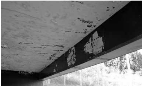
塗料がはがれたベンチの壁
