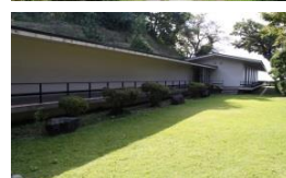
上：管理棟、下：展示棟 全体的に優雅な回廊形式の造りとなっています。
