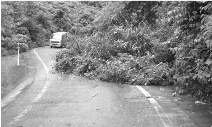
町道豊橋常楽寺線の被害状況
