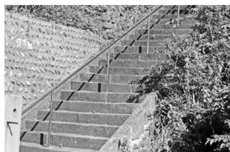
整備の進む津波避難道（尼瀬地内）
