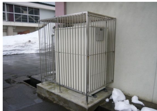
給食室ボイラー完成
