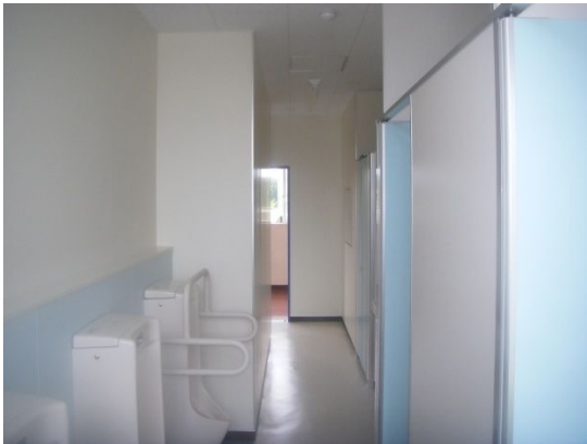
出雲崎中学校トイレ施設完成
