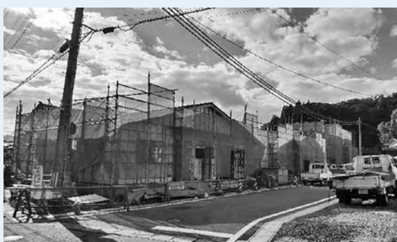
建替工事中の大門町営住宅
