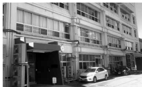
築約48年の小学校校舎
