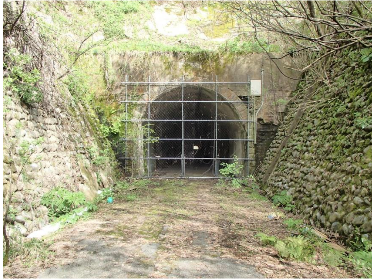
中永トンネル
