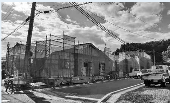
建替工事中の大門町営住宅
