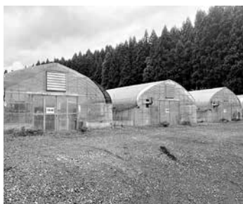
新規園芸施設事業補助金の利用施設
