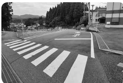
道路新設改良舗装（川西）
