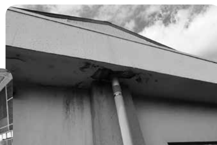
中学校外壁（工事前）
