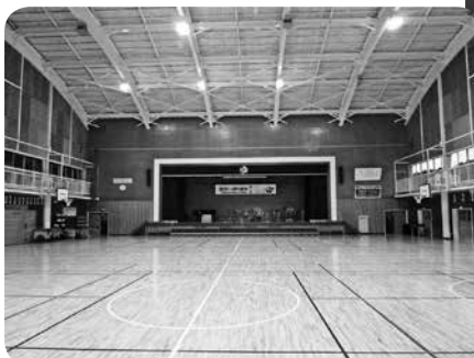
照明等落下防止工事（小学校体育館）
