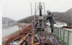
ため池堤体の調査
