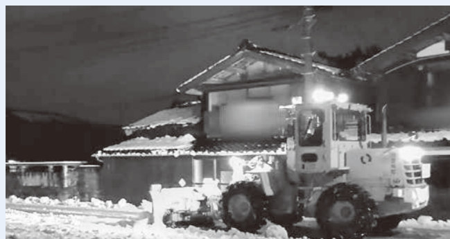
町の除雪作業の様子
