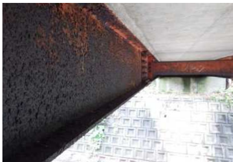
鋼桁の腐食等
