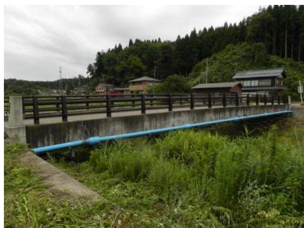
写真全景 (コンクリート橋)
