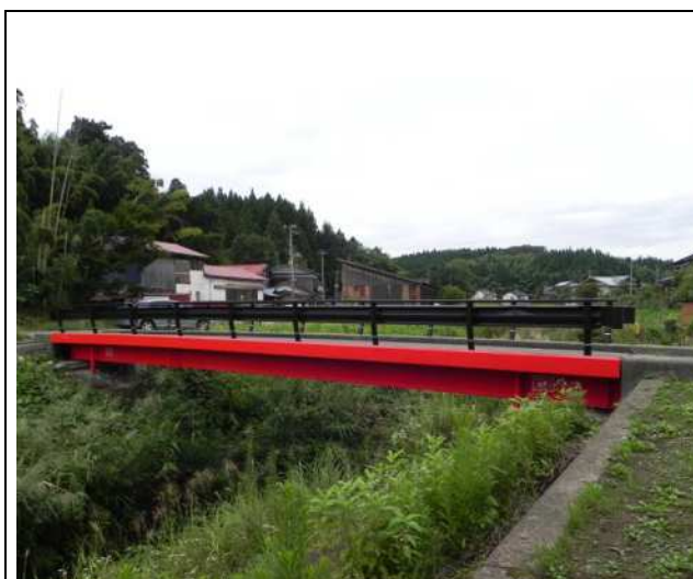
写真全景 (鋼橋)
