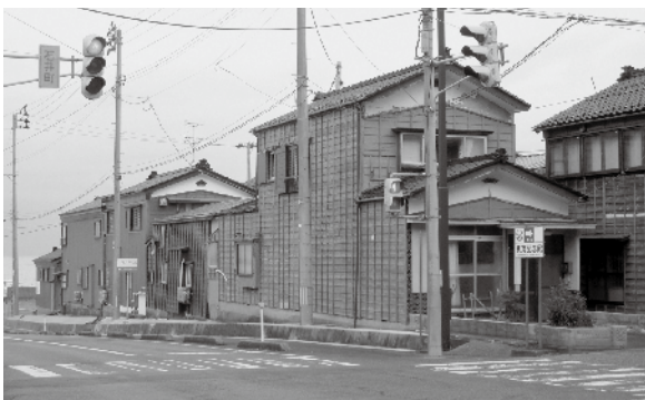
耐震診断する町有物件 (石井町)
