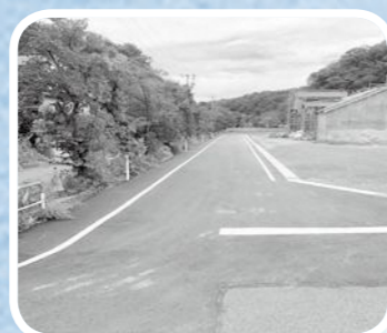
町道八王子2号線道路新設工事 (米田地内)
