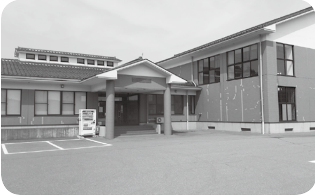
西越地区農村環境改善センター
