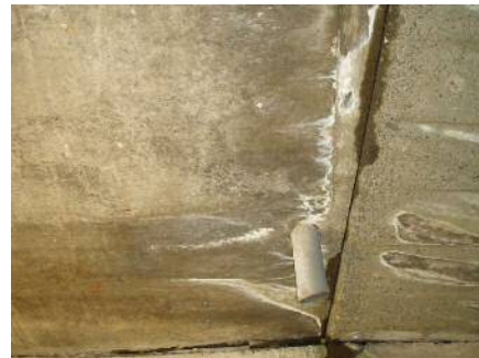
コンクリート床版の漏水・遊離石灰等 （井鼻橋）
