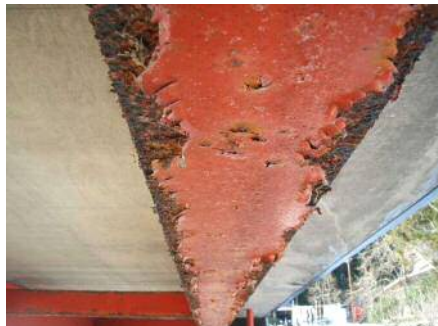
鋼桁の腐食等 （三栄橋）
