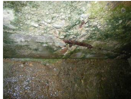
コンクリート床版の剥離・鉄筋露出等 （前田1号橋）
