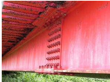
鋼桁の腐食等 （糺屋橋）
